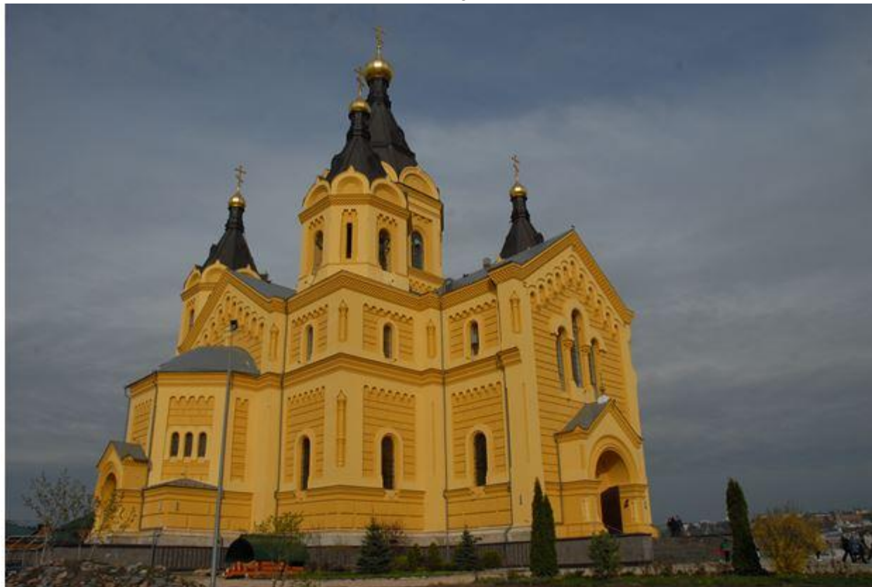
Фото 1. Общий вид с северо-западной стороны
