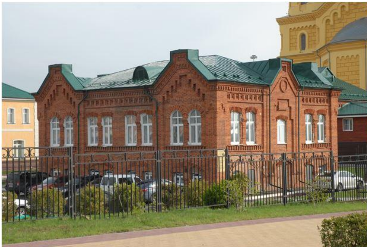
Фото 5. Общий вид с северо-восточной стороны
