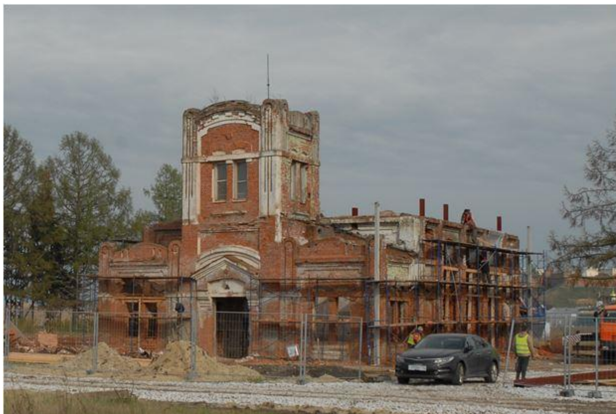
Фото 9. Общий вид с северо-западной стороны
