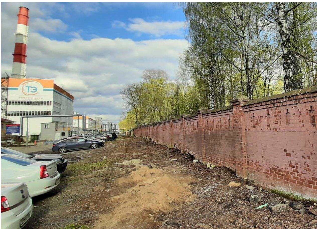
Общий вид кирпичной ограды ансамбля «Комплекс городского (нового) кладбища» в районе восточной части проектируемой трассы электрических сетей на ул. Ветеринарной. Фото 05.05.2021.
