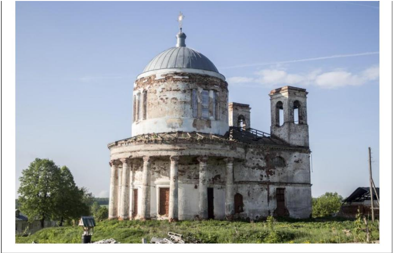
Объект культурного наследия регионального значения «Покровская церковь», расположенный по адресу: Нижегородская обл., Дальнеконстантиновский р-н, с. Борисово-Покровское, д.360.
