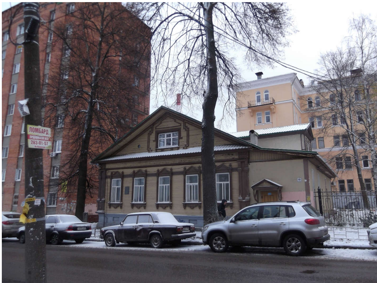
Общий вид на Дом, в котором в 1902-1904 годах жил писатель Чириков Евгений Николаевич, с западной стороны по ул. Гоголя. Вид на главный фасад.
